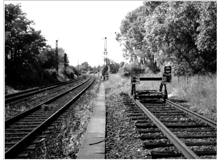
Rückgebaute Abzweig der Kalibahn an der Eisenbahnstrecke Königslutter-Braunschweig
