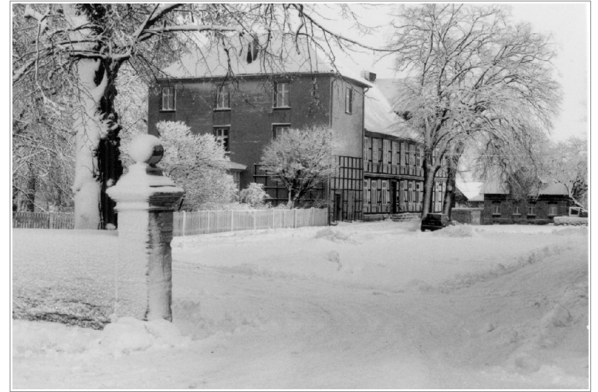
Gebäude von der Hofseite
