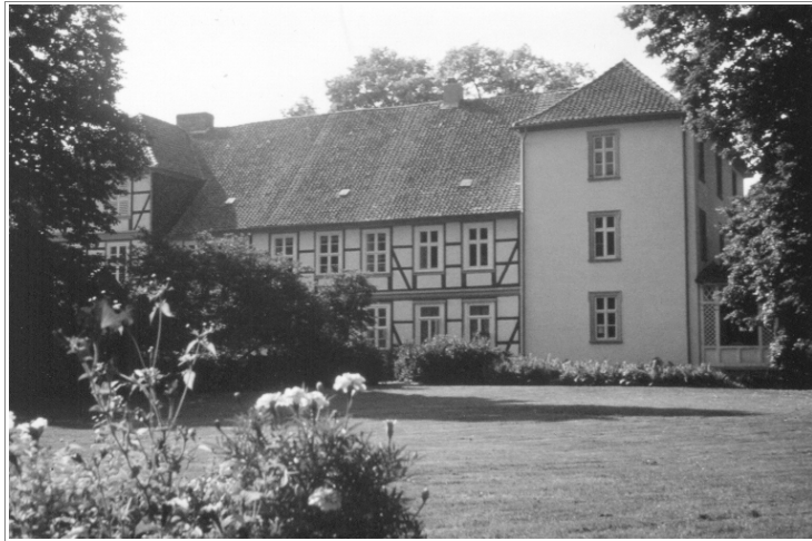
Gebäude von der Gartenseite
