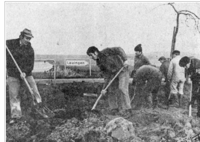
Arbeiten in Eigenleistung zum Anschluss des Sportplatzes an das Wasser- und Elektonetz im Herbst 1972
